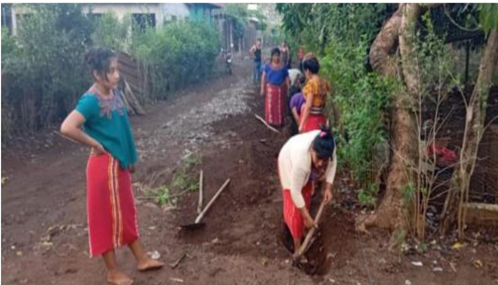
Instalación de la Red de distribución de Agua, Comunidad El Tesoro Nueva Esperanza (Patulul, Suchitepéquez)
